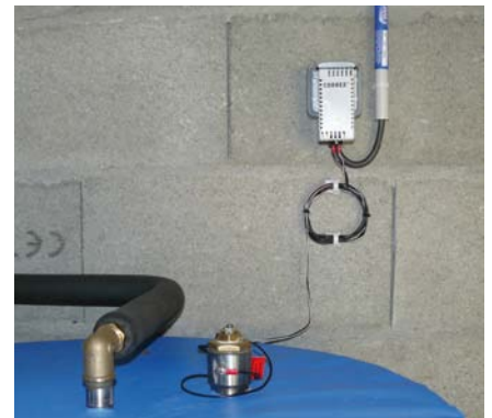
L'anode à courant imposé doit être vérifiée régulièrement
