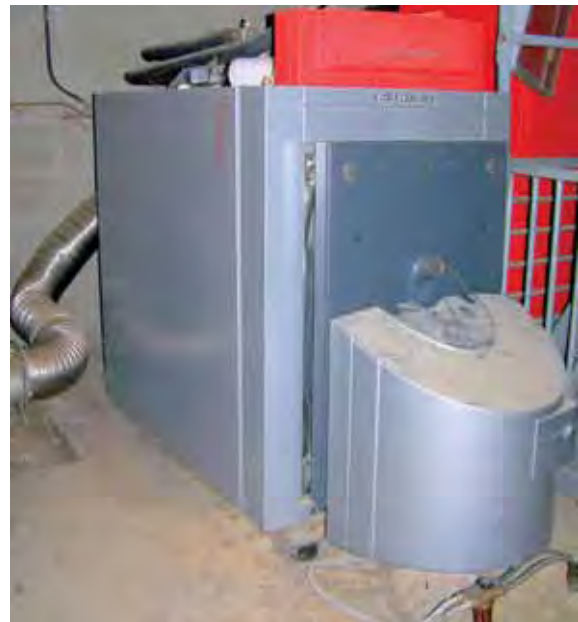
Photo 11: chaudière au sol couplée à un ballon tampon (échangeur)
