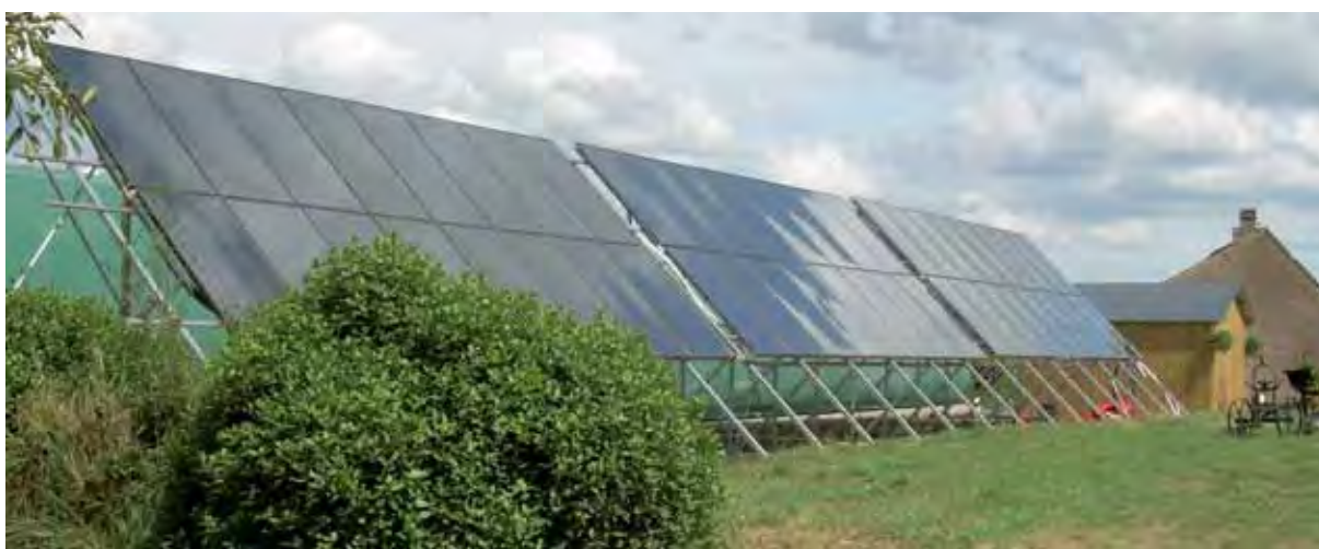
Photo 16 : avec les capteurs solaires, un chauffage d'appoint est nécessaire pour compléter le chauffage de l'eau.
