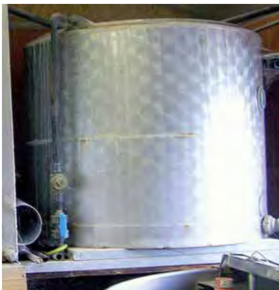
Photo 8 : réservoir ouvert à la pression atmosphérique
