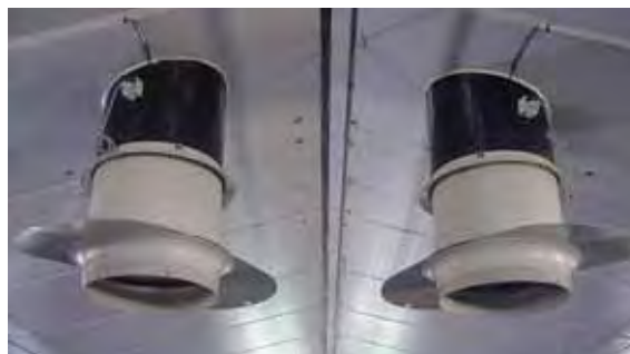
Photo 5: le fonctionnement des ventilateurs représente près de 90 % des consommations électriques du bâtiment (hors chauffe-eau), soit 39 kWh/veau
