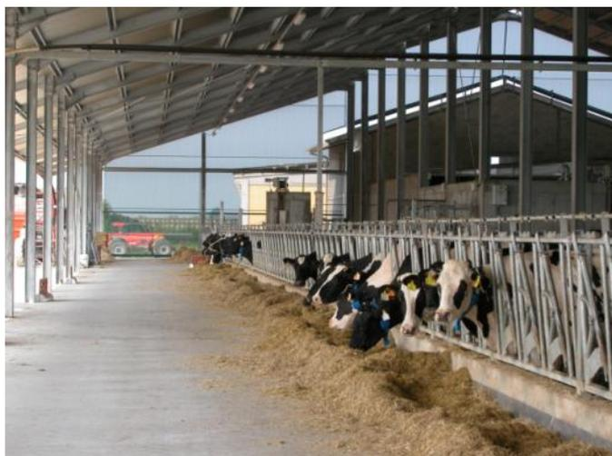
Grande structure métallique 14 m au faîtage – 33% de pente pour la maîtrise de la température l'été. Une structure plus basse au dessus de la salle de traite. Pas de translucides.
