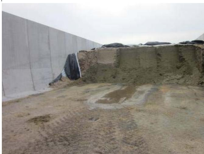
Silos panneaux autostables 5 m / 2,4 m – 288 €/m<sup>2</sup>
