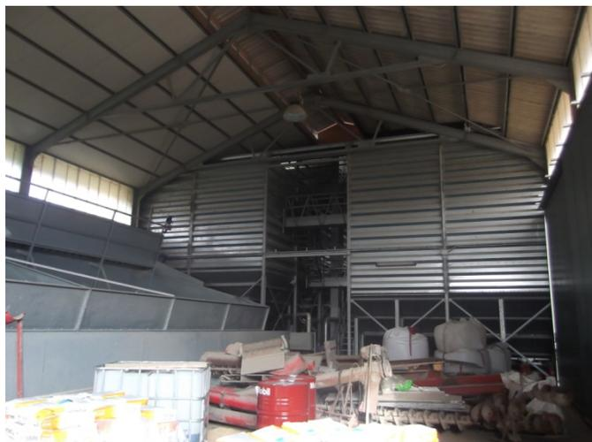
Les cellules métalliques de stockage assurent la structure du bâtiment. Le riz est séché dans des tamis à air chaud (36°C).
