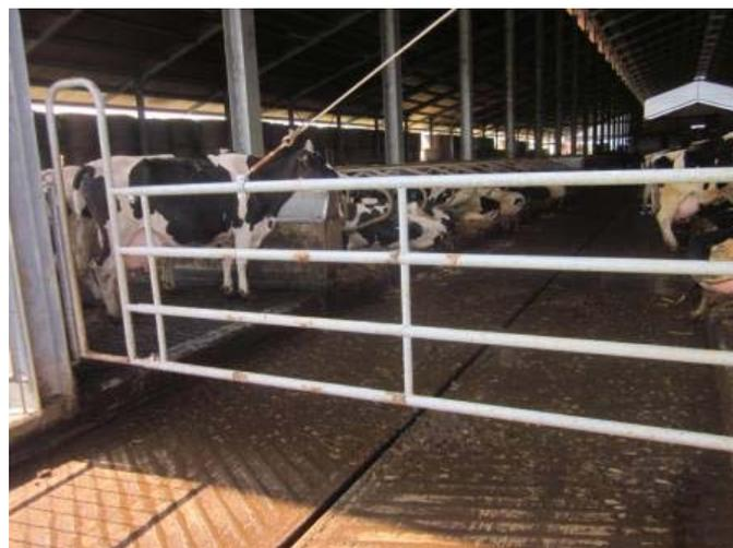
Rainurage de l'aire d'exercice en épi réalisé sur béton frais. Logettes creuses paillées mécaniquement 1 fois / semaine.
