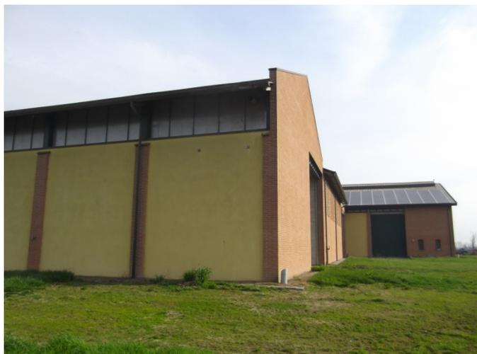
Bâtiment de stockage et de séchage du riz. Structure métallique et parements briques / peinture jaune « Lombard »
