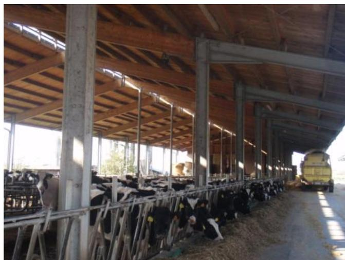
La structure est faite de poteaux métal, arbalétriers lamellé-collé, pannes et voliges bois, isolation, couverture fibres-ciment.
