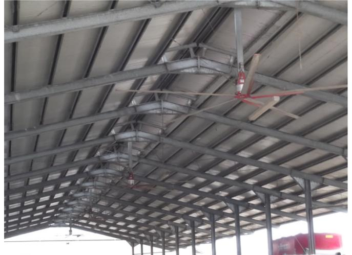
Nouvelle structure charpente métallique et couverture isolée.
