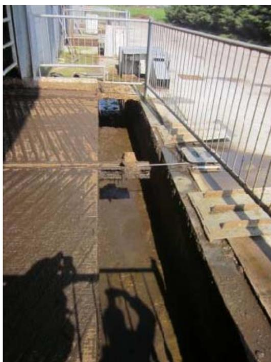
Caniveau de récupération du lisier en bout de racage Forte pente et flushing par reprise du lisier dans la préfosse.
