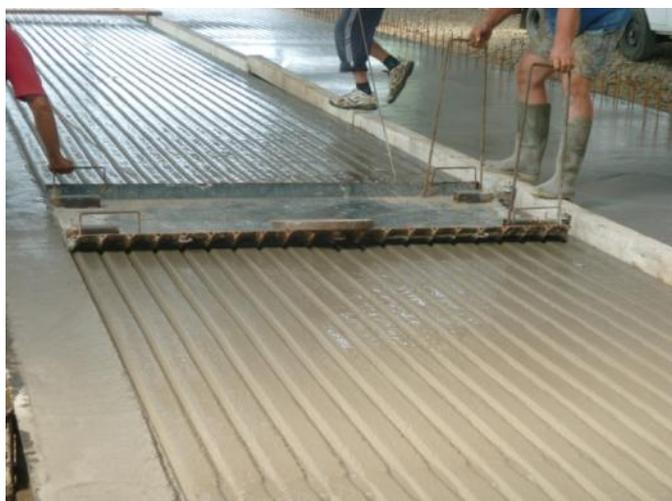
Rainurage sur béton frais (30 mn) à la boucharde.
