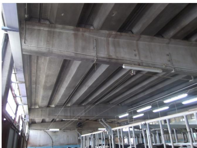
Structure et couverture béton armé sur la salle de traite.
