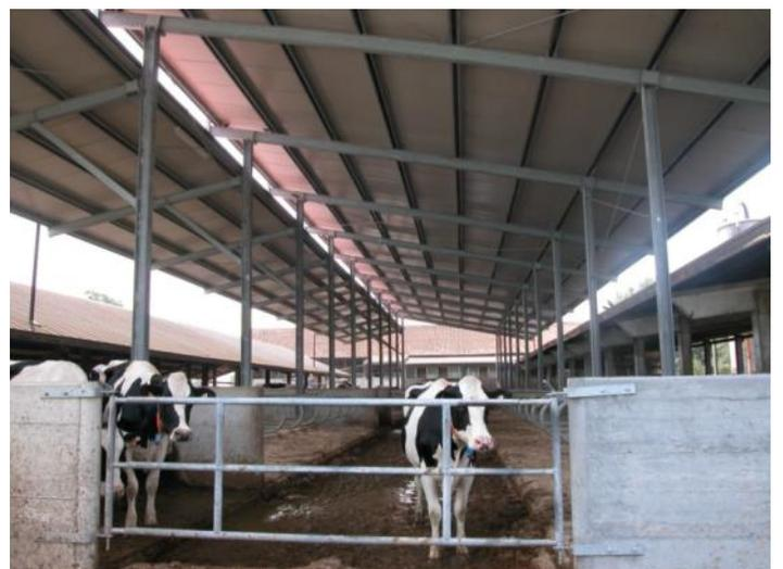
La couverture est en panneaux sandwichs de 35 mm
