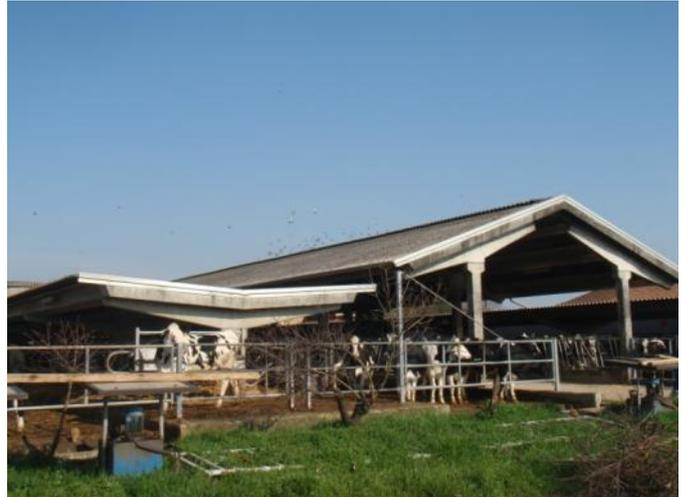
Anciens bâtiments 1993 structure béton (poteaux et ferme)
