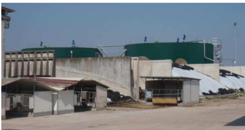
Unité de méthanisation de 250 kW. Essentiellement alimentée par le maïs ensilage. La réglementation interdit de dépasser la hauteur des murs dans la réalisation des tas d'ensilage. Les murs sont en blocs préfabriqués autoporteurs 5m de haut.
